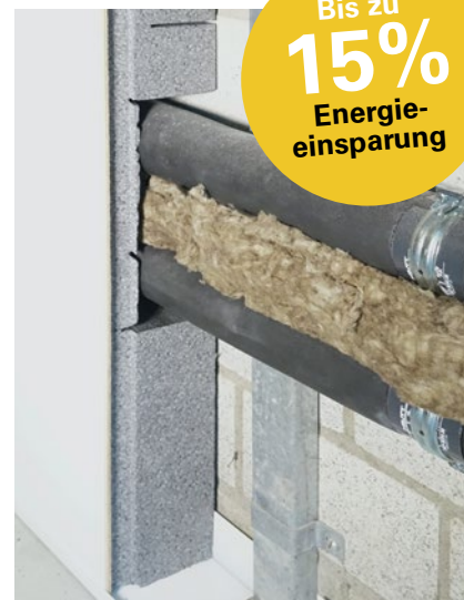
Bestehende Leitungen können massgenau ausgeschnitten werden.
