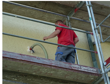
Fachleute blasen die Kerndämmung in die Hohlräume der Fassaden ein.
