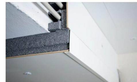
«Attica-Therm» Typ DW-Detaillösung bei Betonunterzug mit Heizleitung.
