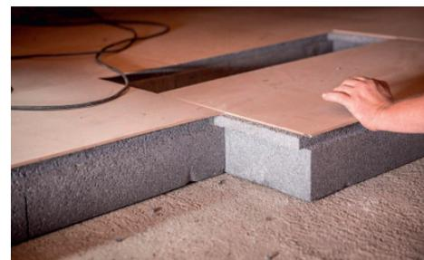
Die Platten lassen sich ganz einfach zusammenschieben; kein Schrauben oder Kleben notwendig.
