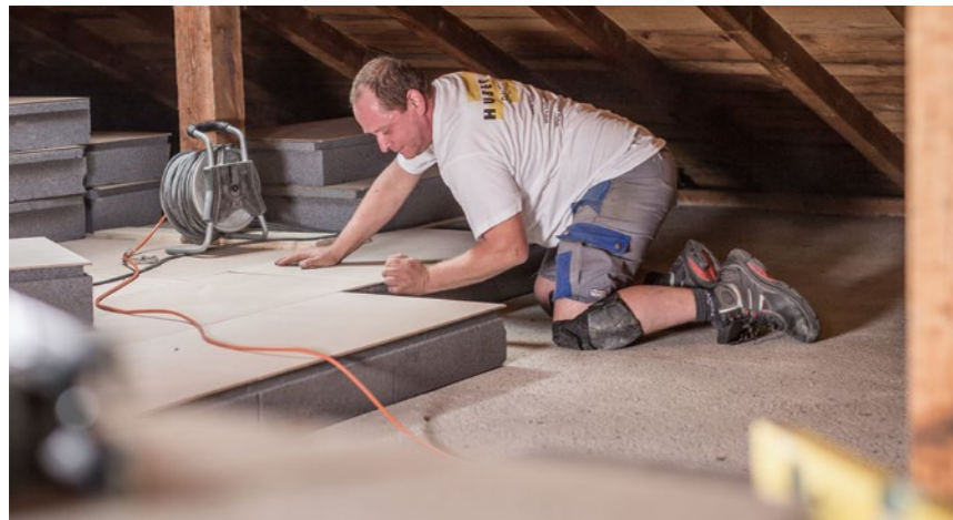
Schnelle und einfache Montage der Estrichbodendämmung Typ AT.
