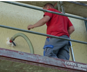
Das Dämmmaterial wurde von aussen eingeblasen.
