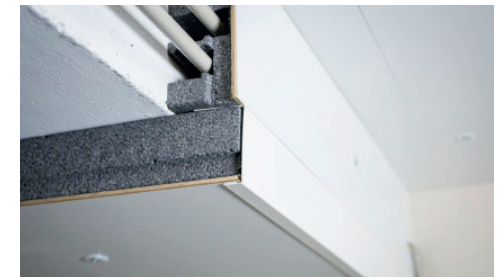
Das feuchtigkeitsbeständige System für Kellerdecken und Wände hat einen hohen Dämmwert.
