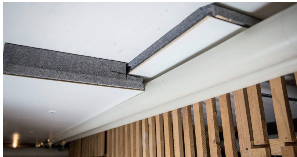
Die weisse Verbundplatte Typ DW für Kellerräume hilft auch Beleuchtungsenergie zu sparen.
