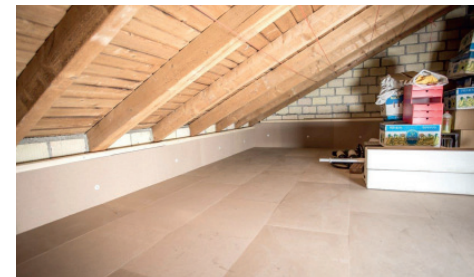
«Attica-Therm» Typ AT ist begehbare und belastbar und eignet sich daher besonders für Estriche.
