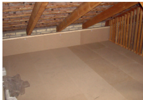
«Attica-Therm» Typ AT ist begehbare und belastbar und eignet sich daher besonders für Estriche.
