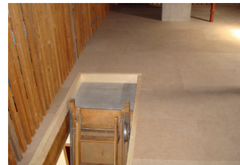
«Attica-Therm» Typ AT ist begehbare und belastbar und eignet sich daher besonders für Estriche.
