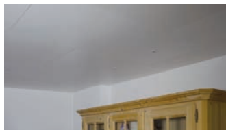
Kellerdeckendämmung Typ DW (kaltseitig)
